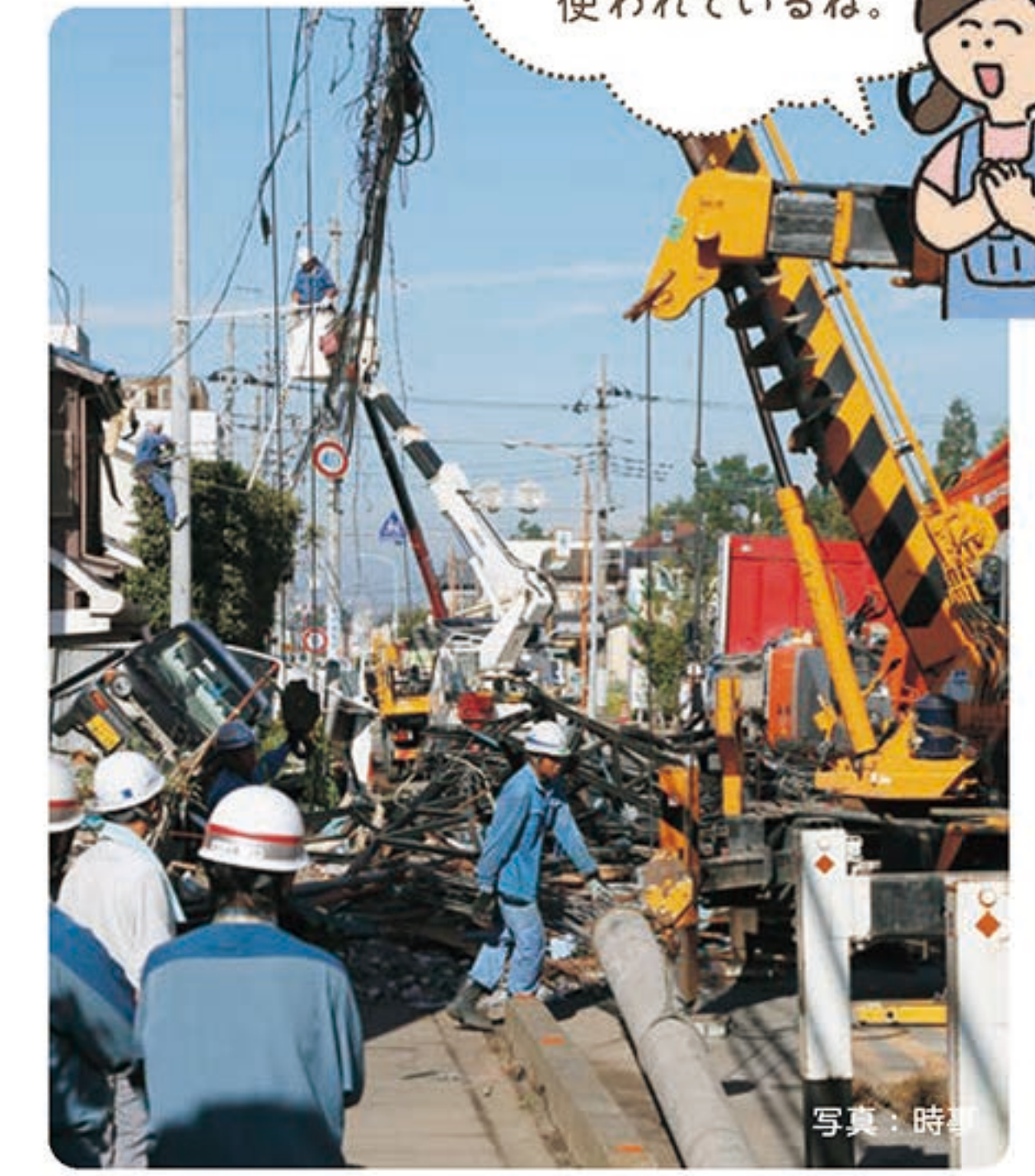
災害のあとに電気の復旧をする作業。
