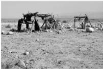
▲井戸掘り作業。まわりの土地はかわわいて砂漠化している。(写真：ベシヤワール会)
