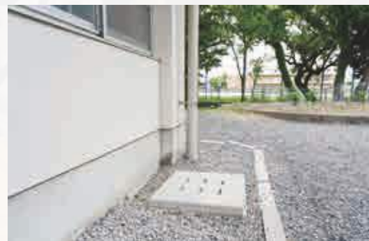
学校にもある雨水ますのパイプ。雨水をあつめてながし、大雨のときの洪水や浸水をふせている。
