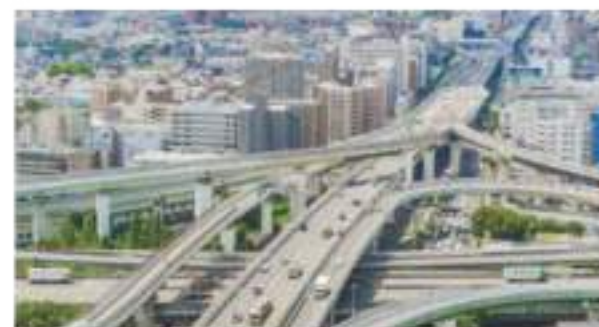
日本の物流・経済をささえる高速道路。老朽化がすすみ、大規模な改修工事が必要な道路もある。
