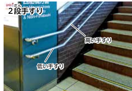
上下2段の高さの手すりがあれば、自分が使いやすいほうをもって体をささえられる。
