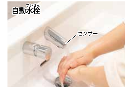
蛇口の下に手をかざすだけで水が流れば、ハンドルをまわさなくても手洗いができる。
