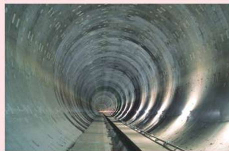
地下に雨水を一時的にためておく施設。
